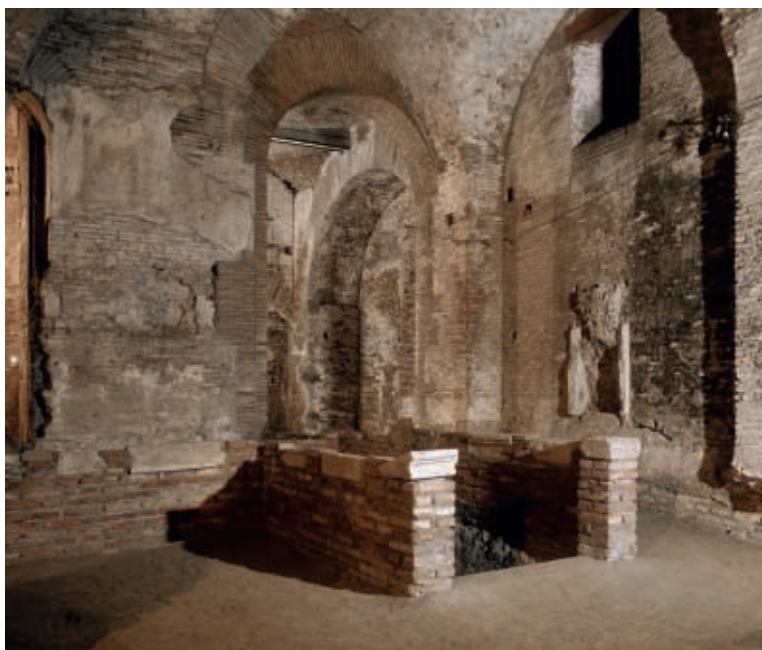
Particolare dell'aula con le scale per i locali sotterranei
