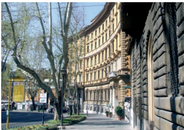
La facciata curvilinea dell'Hotel Majestic
