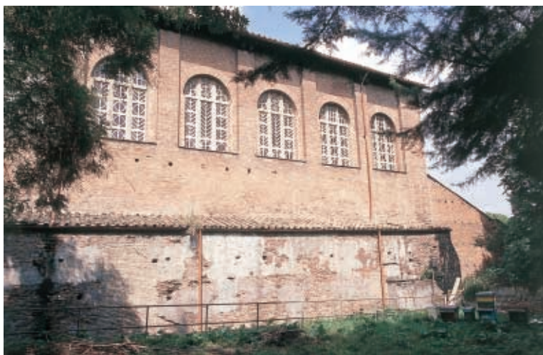
Parete laterale sinistra di S. Balbina: particolare del finestrato
